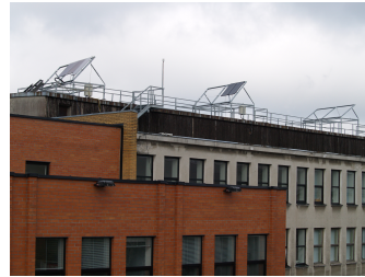
Päikesepaneelide katsetused TTÜ V korpuse katusel
